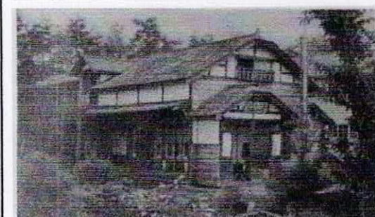
厚生協会わかふじ寮創設当時の建物
